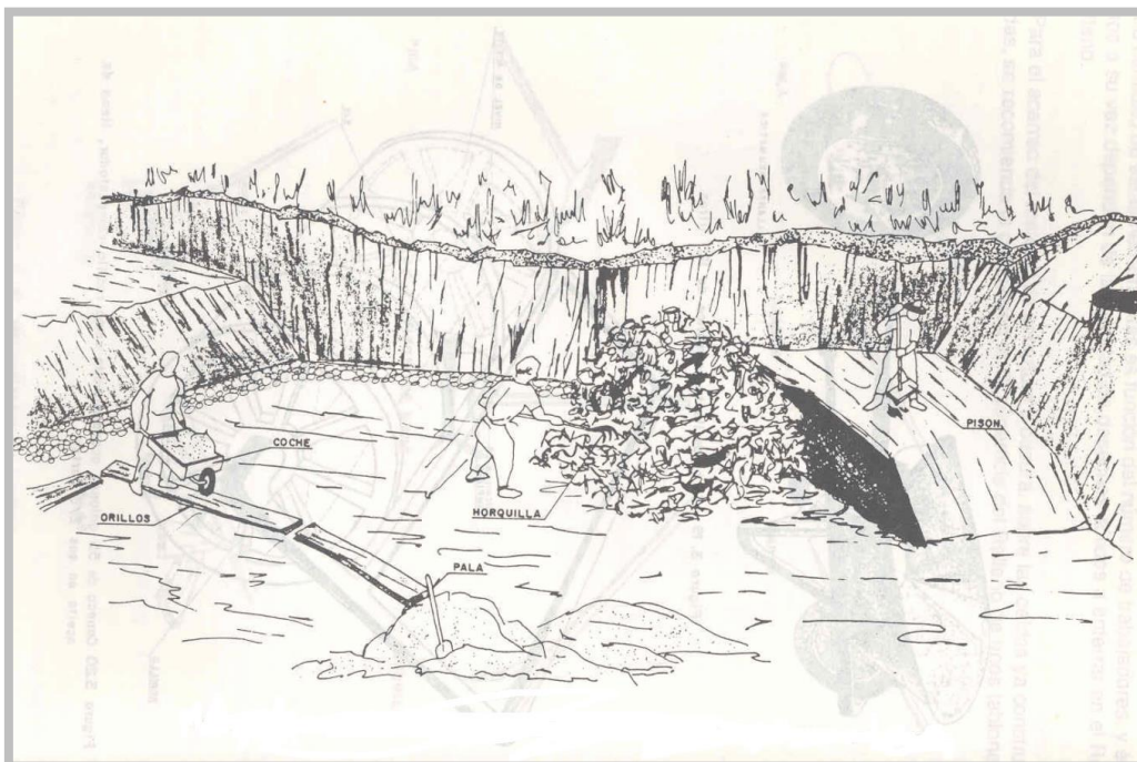
Figura 12. Conformación de celdas en la plataforma de operación
