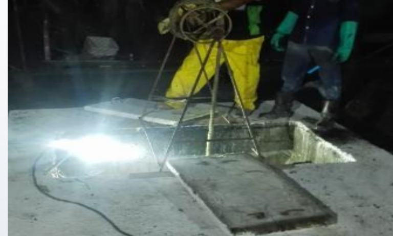
Mantenimiento al sistema de rebombeo del B. Victoria, por el equipo operativo de la empresa
