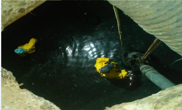
Mantenimiento al sistema de rebombeo del B. Paraíso, por el equipo operativo de la empresa
