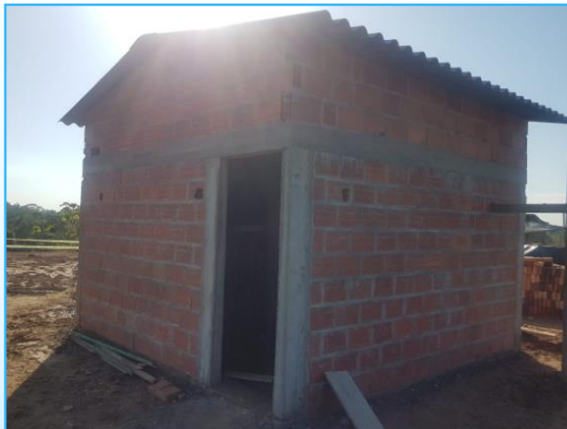
Foto 2. Construcción de Caseta de operaciones
