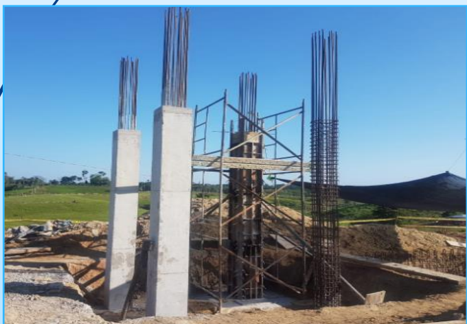
Foto 4. Construcción de Columnas para tanque elevado
