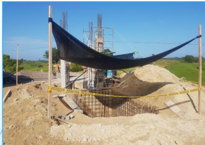
Foto 1. Construcción de tanque subterráneo
