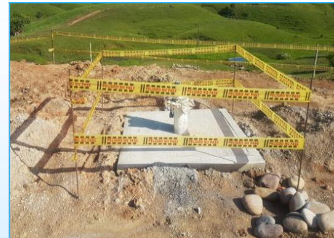
Foto 3. Construcción de Pozo profundo Q: 1L/S
