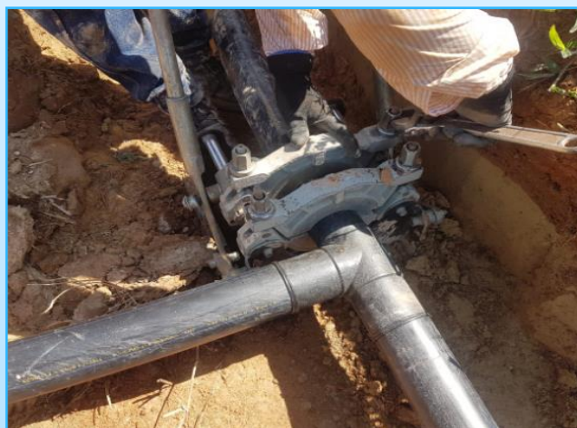
Foto 5. Instalación de RED en tubería PEAD 3" para Distribución
