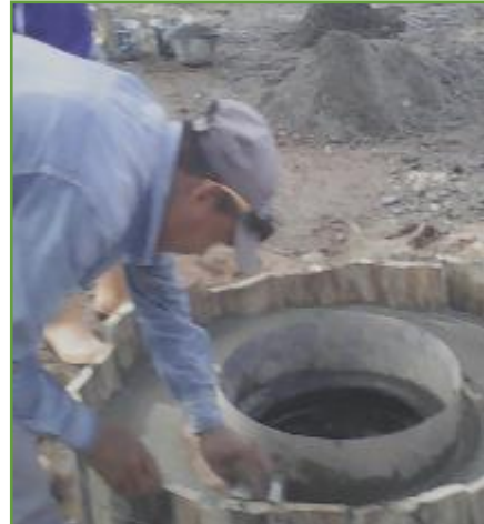
Rehabilitación de manholes
