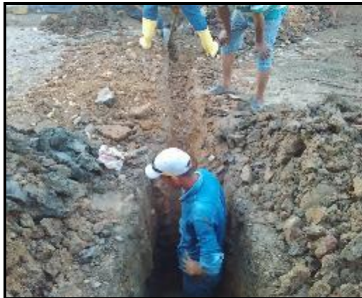
Acometidas de alcantarillado
