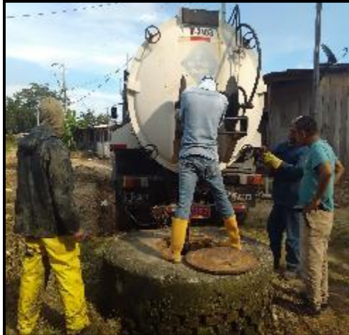
Limpieza mecánica de manholes
