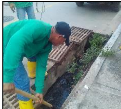
Limpieza de sumideros
